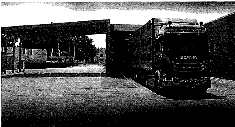
De overkapping bij VION Apeldoorn
